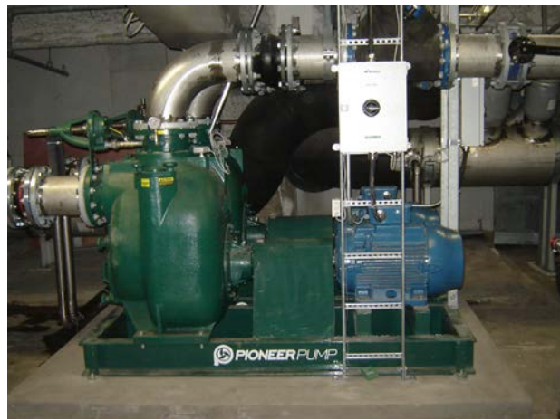
KUVA 5. Esimerkki itseimevästä jätevesipumpusta
